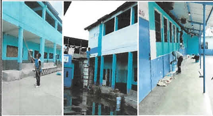
Foto7: APLICACIÓN PINTURA DE PAREDES INTERIOR
