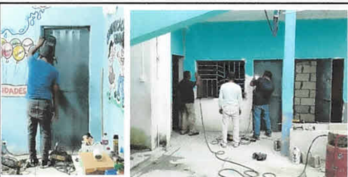
Foto 5: CAMBIO DE 4 PUERTAS
