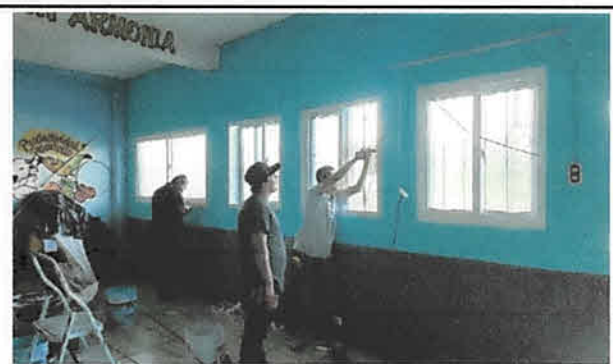
Foto 12: INSTALACION DE VENTANAS PVC
