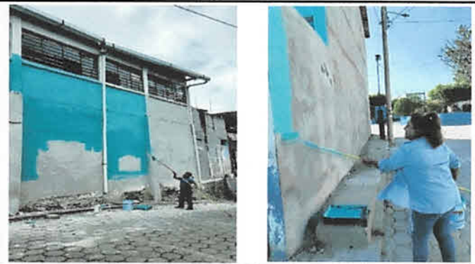
Foto 8: APLICACIÓN DE PINTURA EXTERIOR
