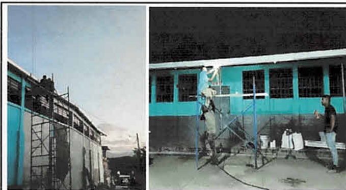
Foto 9: INTALACION CANAL DE AGUA Y BAJADAS
