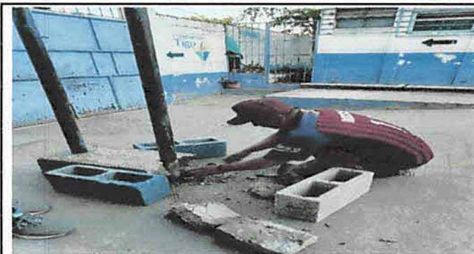
Foto 11: REPARACION DE BASE DE CONCRETO PARA ASTAS DE BANDERAS
